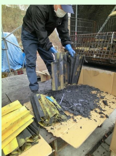
汚泥落とし作業
